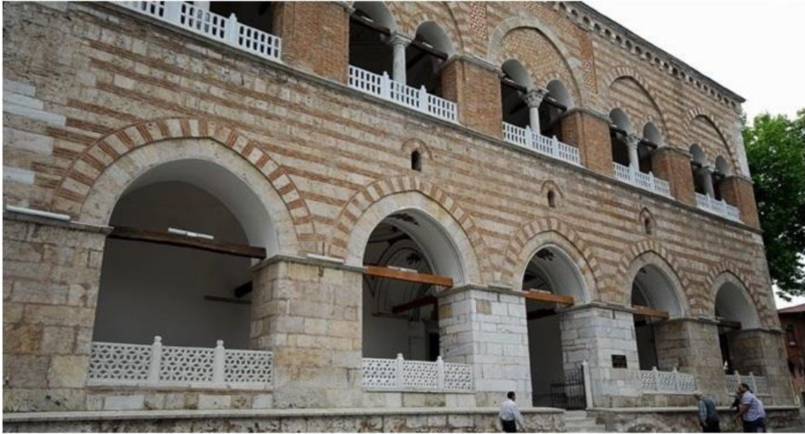
Resim 3: Hüdavendigar Camii dış cephe genel süsleme kompozisyonu
